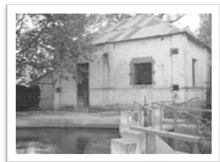
"La Turbina", generadora de electricidad
