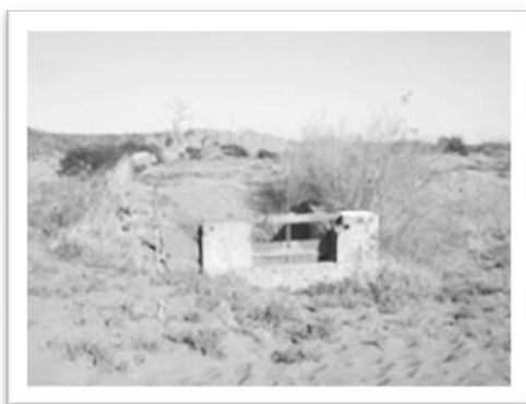
Estructura de antiguas compuertas
