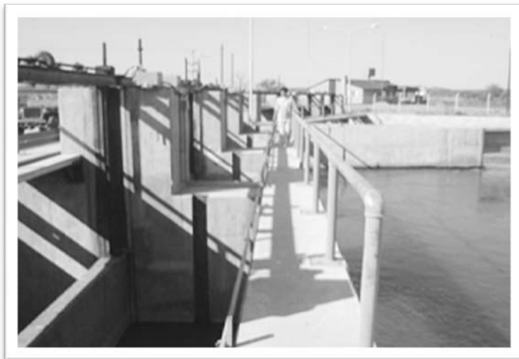
Dique de toma del nuevo canal.
