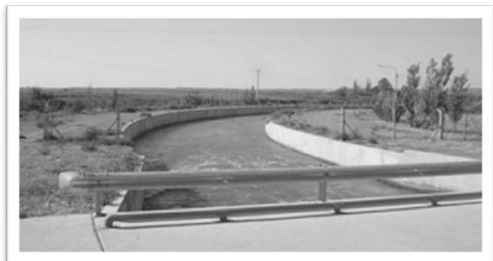
Canal marginal Río Atuel – Primer tramo
